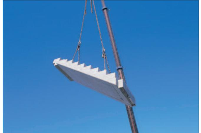
Bild 10: Beton-Fertigteiltreppe am Montagekran
