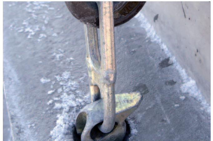
Bild 5: Anschlagen der Treppe am Transportanker
