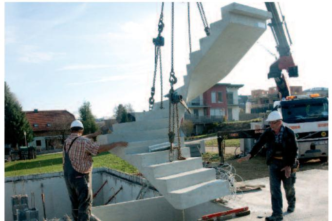
Bild 11: Einheben der Treppe in Montagelage
