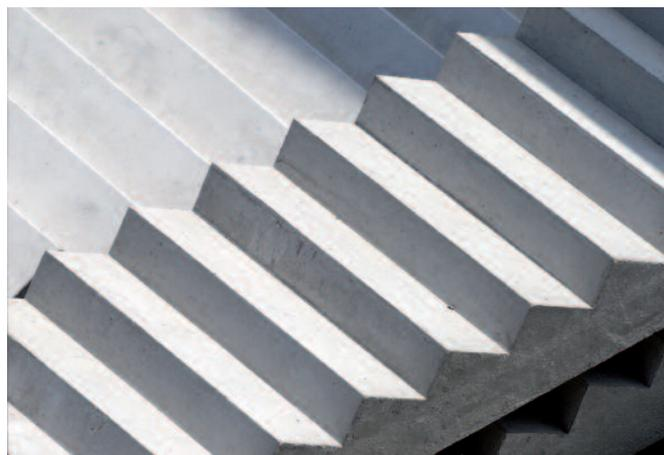
Bild 2: Gerade Beton-Fertigteiltreppe
