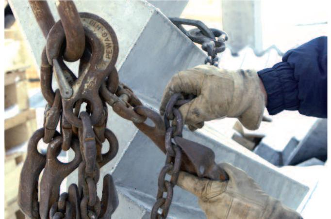
Bild 4: Anlegen des Montagegehänges
