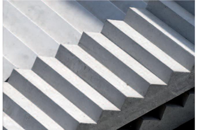
Bild 16: Gerade Beton-Fertigteiltreppe
