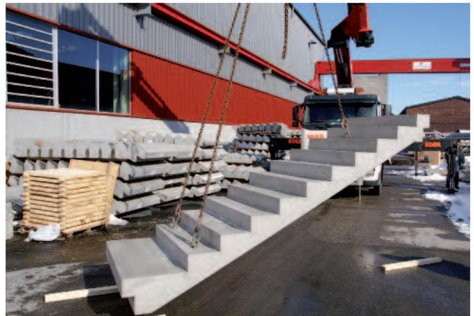
Bild 8: Einheben einer Beton-Fertigteiltreppe
