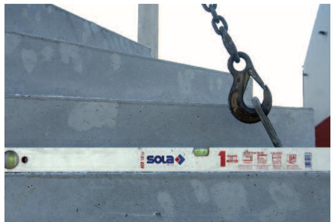
Bild 12: Stufen müssen quer zur Laufrichtung waagrecht liegen
