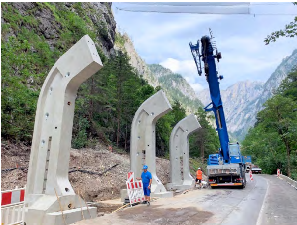
Anlieferung der massiven Sonderfertigteile und Installation der 28 Tonnen schweren Stützen sowie der Wandelemente für die neue Steinschlag-Verbauung an der „Steinerne Jungfrau“ genannten Felswand entlang der L127 Radmerstraße (Steiermark, Bezirk Leoben). Abdruck honorarfrei bei Nennung: © Kirchdorfer
