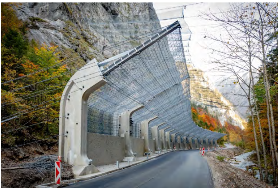
Die Steinschlagverbauung an der „Steinerne Jungfrau“ genannten Felswand wurde im Herbst 2019 fertiggestellt. Abdruck honorarfrei bei Nennung: © DI Walter Klöckl, Hengsberg
